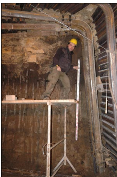
Specifické podmínky práce v podzemí.
