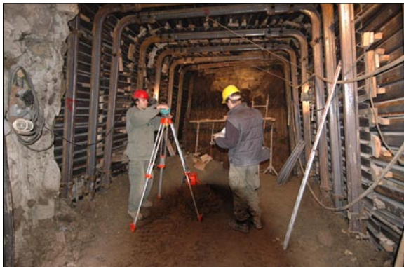
Archeologická dokumentace při ražbě kolektorového tunelu při které bylo objeveno základové zdivo presbytáře nikdy nerealizované dostavby barokního kostela sv. Máří Magdalény. Malá Strana - Karmelitská čp. 387/III.
