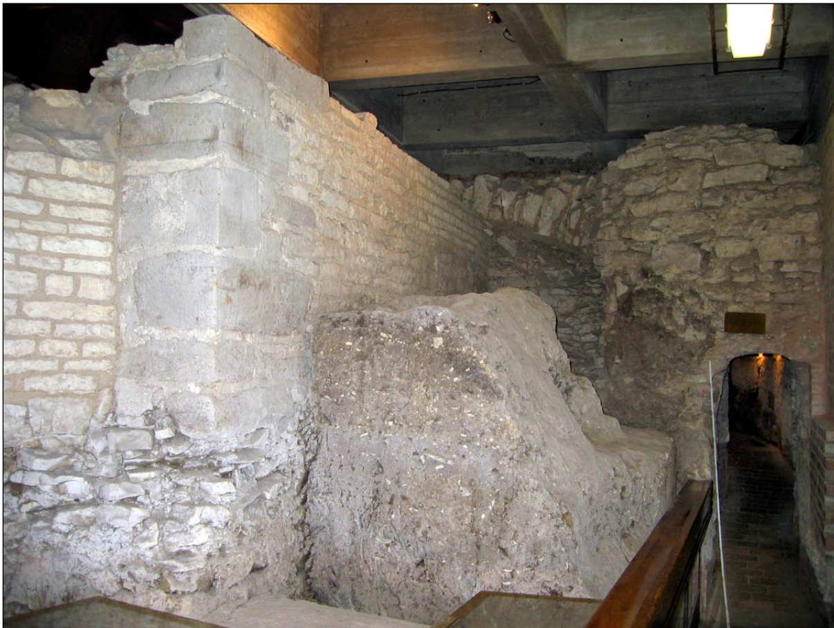
Pohled na severní obvodovou zeď krypty a relikv druhotně upravené románské apsidy.
