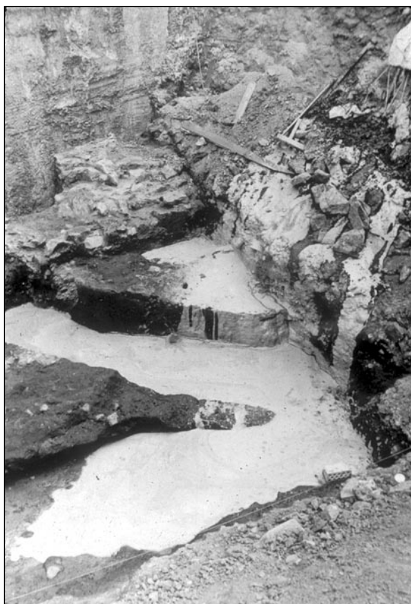
Výzkum probíhal za plného provozu stavby. Občas našli archeologové své vykopané a zčištěné sondy zaplněné bentonitovou směsí.
