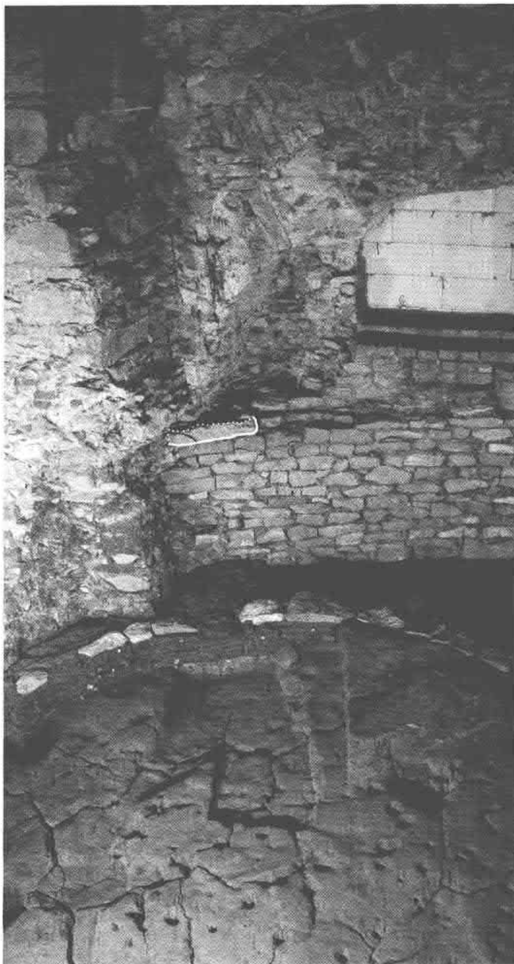
Obr. 16. Z pietních důvodů nebyl kamenný kruh rozebírán a zůstal intaktní, proto není vyřešeno, zda v mezerách mezi kameny mohly být zárubně dveřního otvoru. Ze stejného směru se cca o 150 let později patrně vcházelo přes kámen prahu K34 (jeho dochovaná část je bíle obtažena) do zděného kostela – rotundy (foto L. Smutka, digitalizace M. Ďurica).
