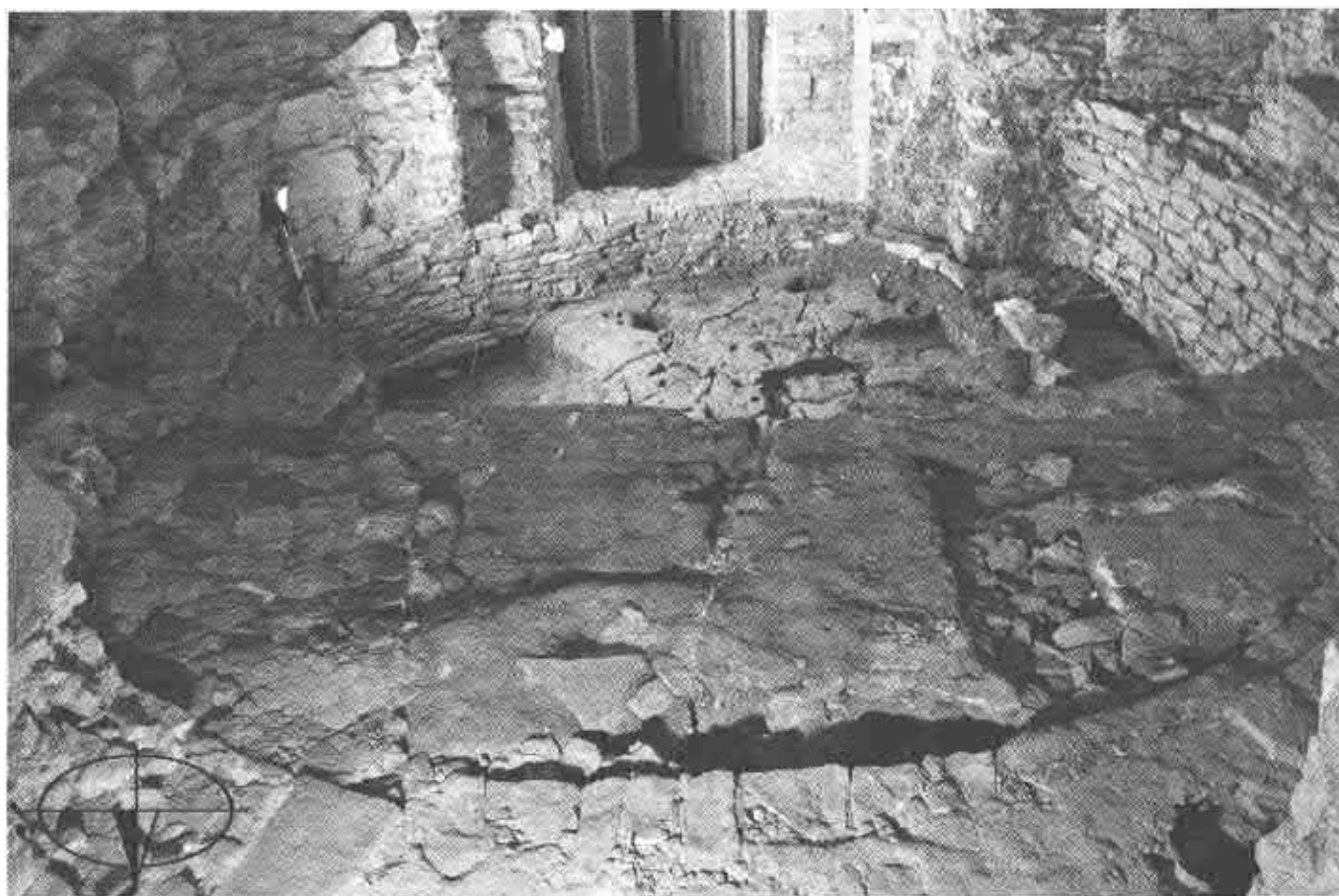
Obr. 5. Rotunda sv. Václava. Pohled od severu k jihu, směrem od ulice do chodby v přízemí, na kruh základového zdiva rotundy. V popředí blok s románskou podlahou na úrovni 200,0 m n. m. (Bpv). Jižní polovina rozebrána na povrch rostlého terénu ve výšce 198,8. Horizonty pravěké jsou skryty v rostlém podloží (foto L. Smutka).
