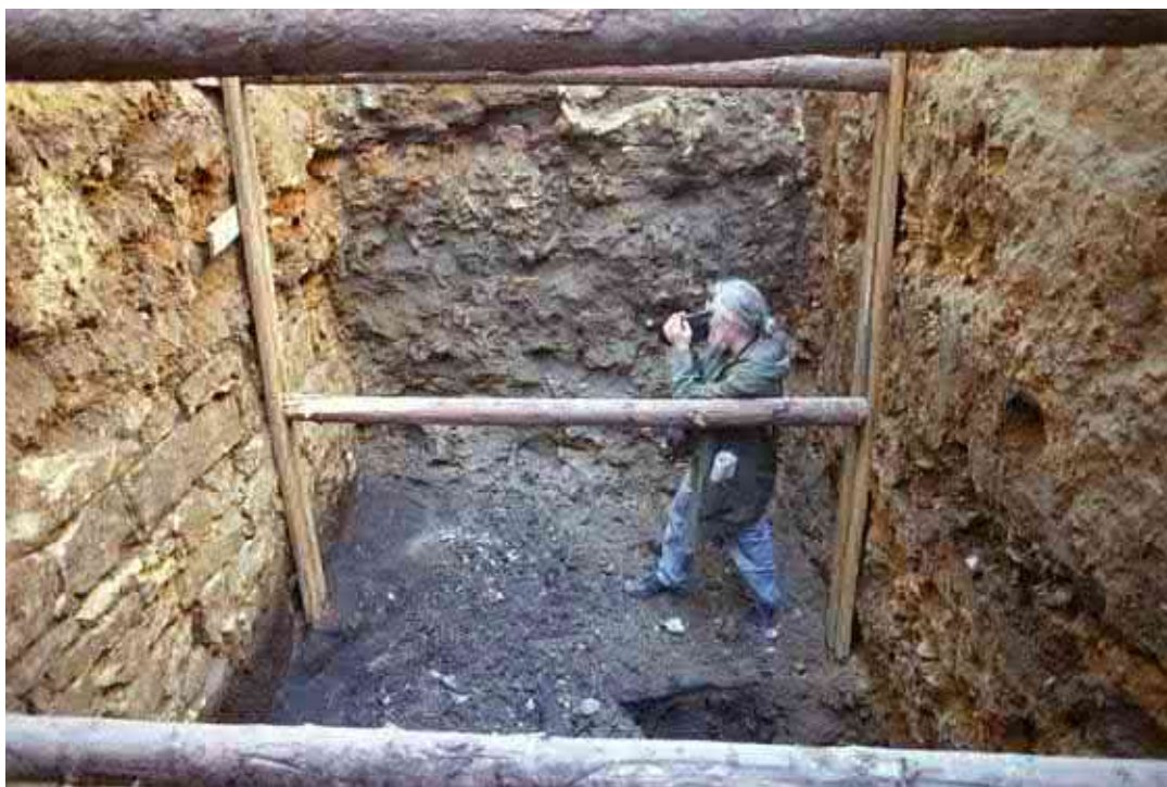
Fotografická dokumentace vnitřního líce jižní zdi původní nájezdové rampy na Karlův most zastížené v sondě VII výzkumu 26/97. Foto: Martin Müller, 1997.
