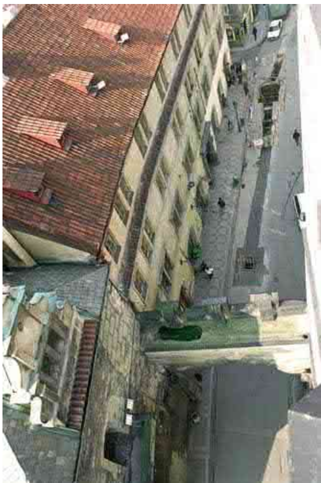
Pohled z větší mostecké věže do Mostecké ulice při dokončování prací pro Telecom. Trasa měřícího kabelovodu je přerušena dvěma kabelovými komorami – nahoře (na západě) sonda VII, před bránou sonda V. Foto: Martin Müller, 1997.
