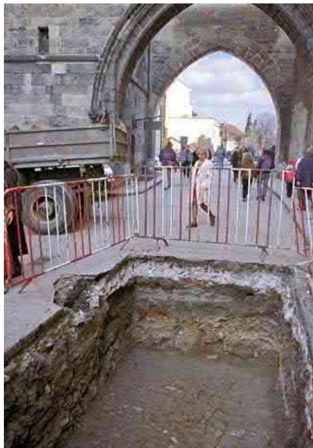
Křemencová dlažba 1,7 m pod dnešní vozovkou (následující obr.: B) vznikla při (nebo po) stavbě větší mostecké věže z 60. let 15. století. Dlažba ilustruje výškovou změnu, která pozměnila proporce brány i obou věží. Foto: Martin Müller, 1997.
