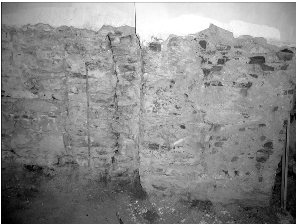
OBŘ. 6: DETAIL ARKÁDY PŘÍZEMÍ VÝCHODNÍ STĚNY PŘŮJEZDU ČP. 249/III S PŘEDLOŽENÝM POLOPILÍŘEM. FOTO M. KOVÁŘ.
