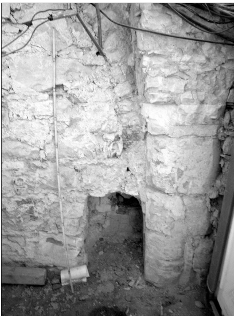
OBR. 7: DETAIL VÝCHODNÍ PARCELNÍ ZDI ČP. 249/III PŘÍZEMÍ S PATRNÝM PILÍŘEM A VÝBĚHEM PASU. FOTO M. KOVÁŘ.
