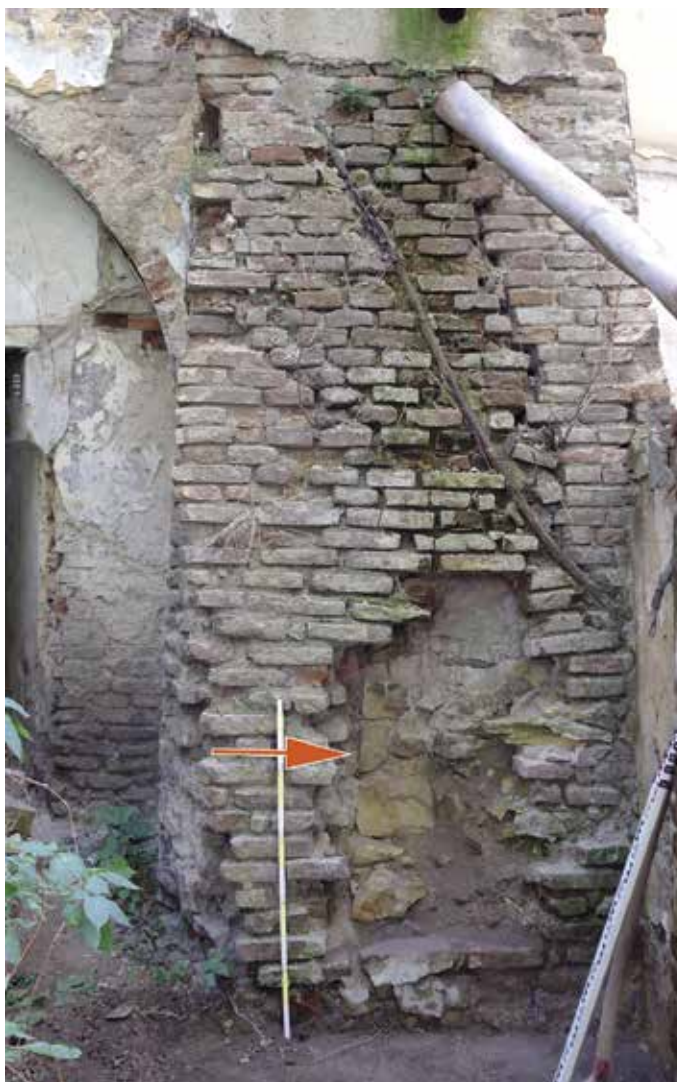
Obr. 10. Praha 1-Staré Město, Bartolomějská čp. 309. Za cihlami opěrného pilíře z 20. století (viz obr. 11: E) je skryta jižní obvodová zeď románského domu. V místě šípky je patrný exteriérový kvádrkový líc zdi (foto M. Semerád, 2012).
