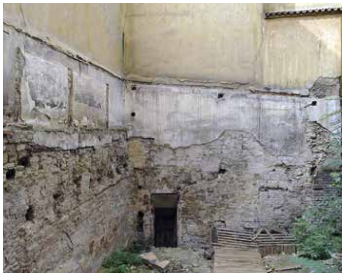
Obr. 5. Praha 1-Staré Město, Bartolomějská čp. 309. Nezastavěný východní dvorek, ve středověku interiér kvádríkového domu. Pohled od ulice Na Perštýně (od severovýchodu) na západní a jižní stěnu dvorku. Zdi ve své hmotě skrývají románské kvádríkové konstrukce (foto M. Semerád, 2012).
