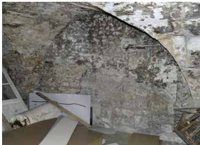
Obr. 14. Praha 1-Staré Město, Bartolomějská čp. 309. Vnitřní líc raně gotické přístavby v úrovni přízemí, jižně od románského domu. Vyzděný je po řádcích z lomo-vých opukových kvádrů vývojově mladší stavební technikou, která se od románského zdiva liší pouze absencí kamenického opracování jednotlivých kvádrů (foto M. Semerád, 2011).
