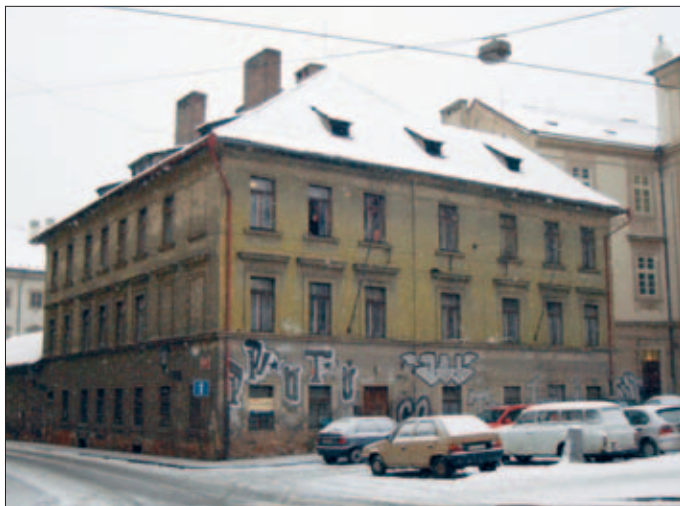
Obr. 9. Nenápadný dům čp. 387 v Karmelitské ulici skrývá ve své hmotě několik výrazných stavebních fází gotického klášterního kostela magdalenitek. Pohled od severozápadu (foto F. Malý, 2004).
