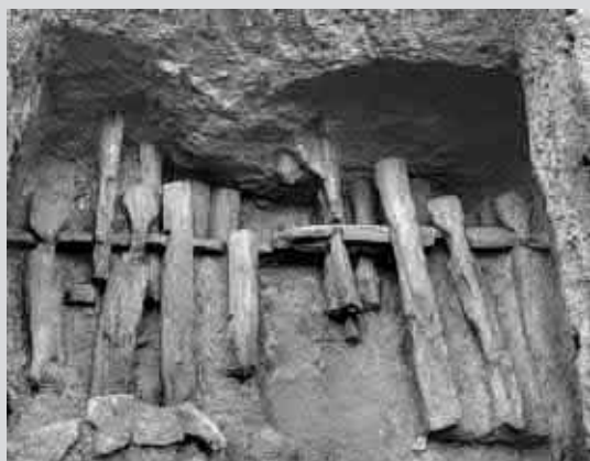
▲ Komerová konstrukce (vzadu) a rošt mladší raně středověké hradby zbudované zřejmě na počátku 2. třetiny 10. století a dochované pod 3. nádvořím Pražského hradu, výřez. © ARÚ Praha, č. neg. FT000103284.
