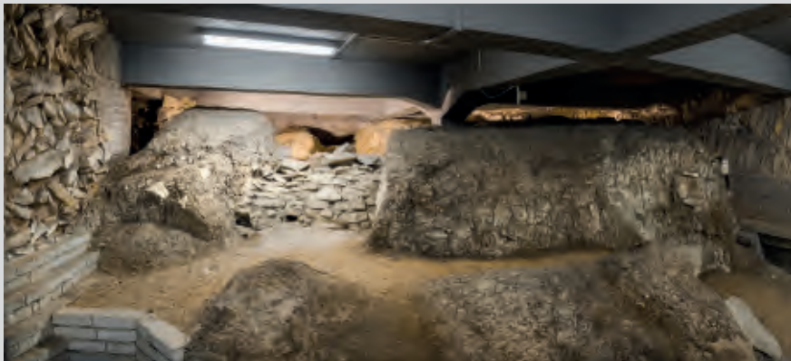
▲ Opevněná plocha Pražského hradu se postupně rozšiřovala směrem k jihu. Tento proces lze sledovat pod 3. nádvořím. Snímek zachycuje výsek čelní stěny nejstaršího opevnění, odkryté pod hliněným tělesem mladší hradby, vzniklé snad ještě ve 30. letech 10. století. Čelo mladší hradby se nachází dále k jihu, mimo záběr snímku. Cihlové obvedivky slouží k ochraně prostoru s unikátně dochovanou dubovou výztuží opevnění. Foto Z. Kačerová, 2014.
