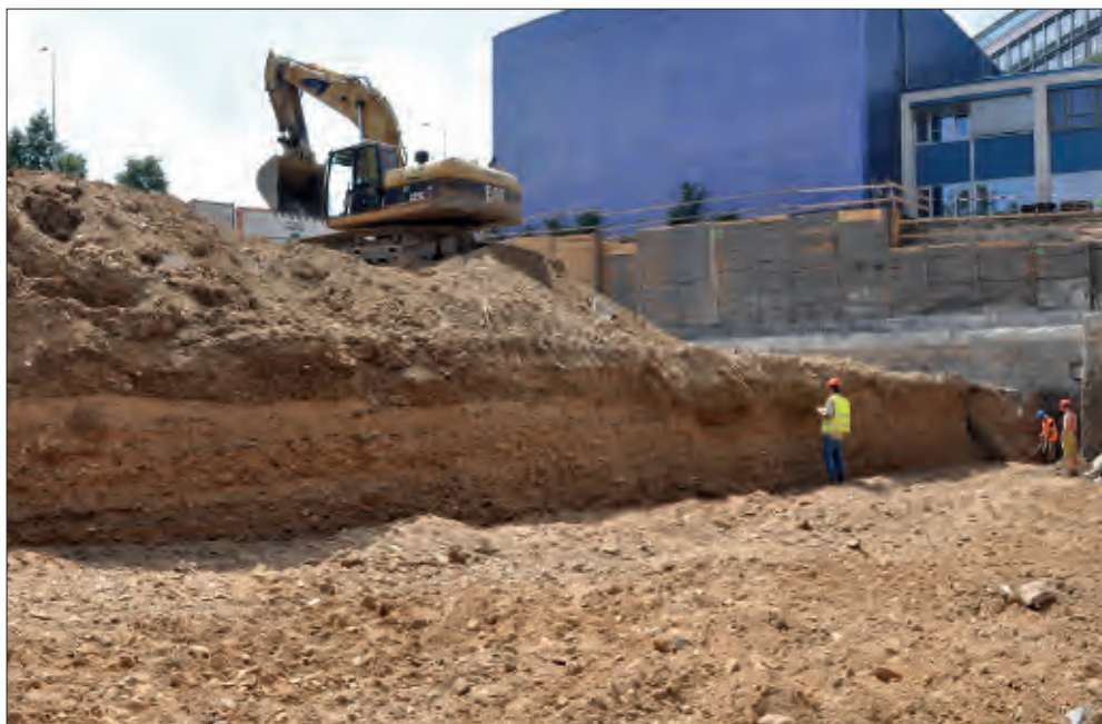
Obr. 3: Praha-Dejvice, ulice Jugoslávských partyzánů. Pohled na jednu z etází generálního řezu s mělkými koryty dvou vodotečí. Foto P. Kacl.
