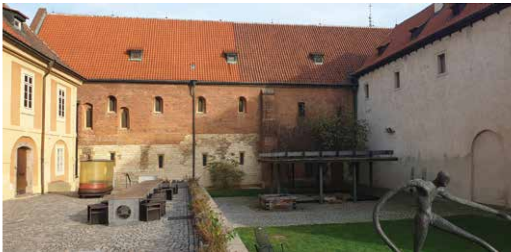
Obr. 32. Praha 1-Staré Město, dnešní stav východní části severní zahrady Anežského kláštera. Pohled od západu na kvádríkové zdivo konventu, vrchní partie cihlová (foto P. Taibl, 2022).
