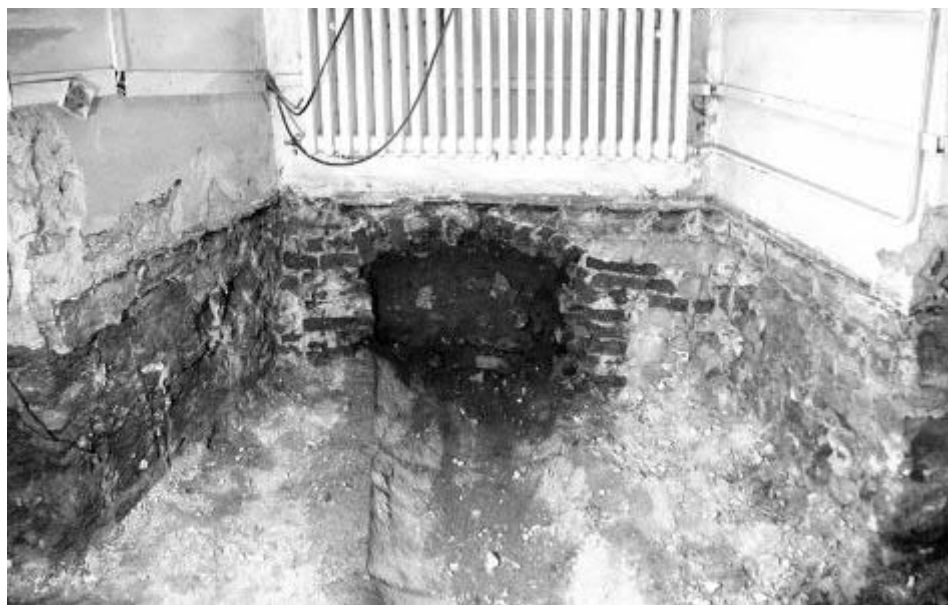
Obr. 20. Klementinum čp. 190, východní část severního křídla jezuitské koleje, pohled od severu na jižní obvodovou zeď. Pod ní se nalézá zaklenutá cihlová stoka (Z01) se dnem z mohutných pískovců. Výzkum NPÚ ÚOP v Praze č. 2010/11, sonda U. Foto J. Havrda.
