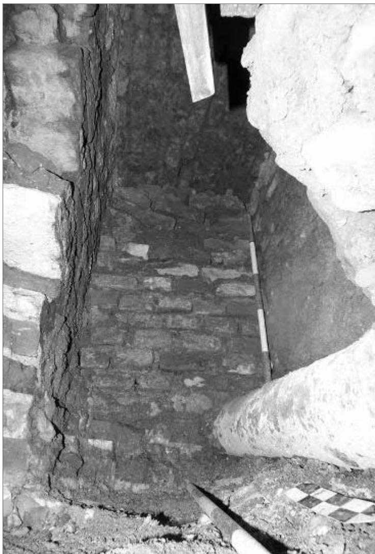
Obr. 16. Platněřská ulice ppč. 1104, snímek prostupu raně barokní kanalizace základovým zdívem severního křídla jezuitské koleje, pohled k jihu. Cihlami zaklenutý průchod uzavřen v 19. století zazdívkou. Výzkum NPÚ ÚOP v Praze č. 2011/15, vedoucí výzkumu J. Havrda. Foto K. Žďárský.
