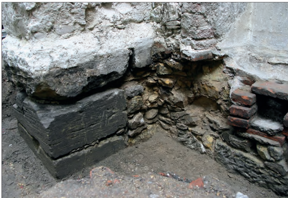
Obr. 11: Praha-Malá Strana, čp. 28/III. Dnešní pilíř na východní straně rajského dvora stojí na gotickém armovaném pilíři a zachovává jeho půdorys (foto M. Müller, 2007).
