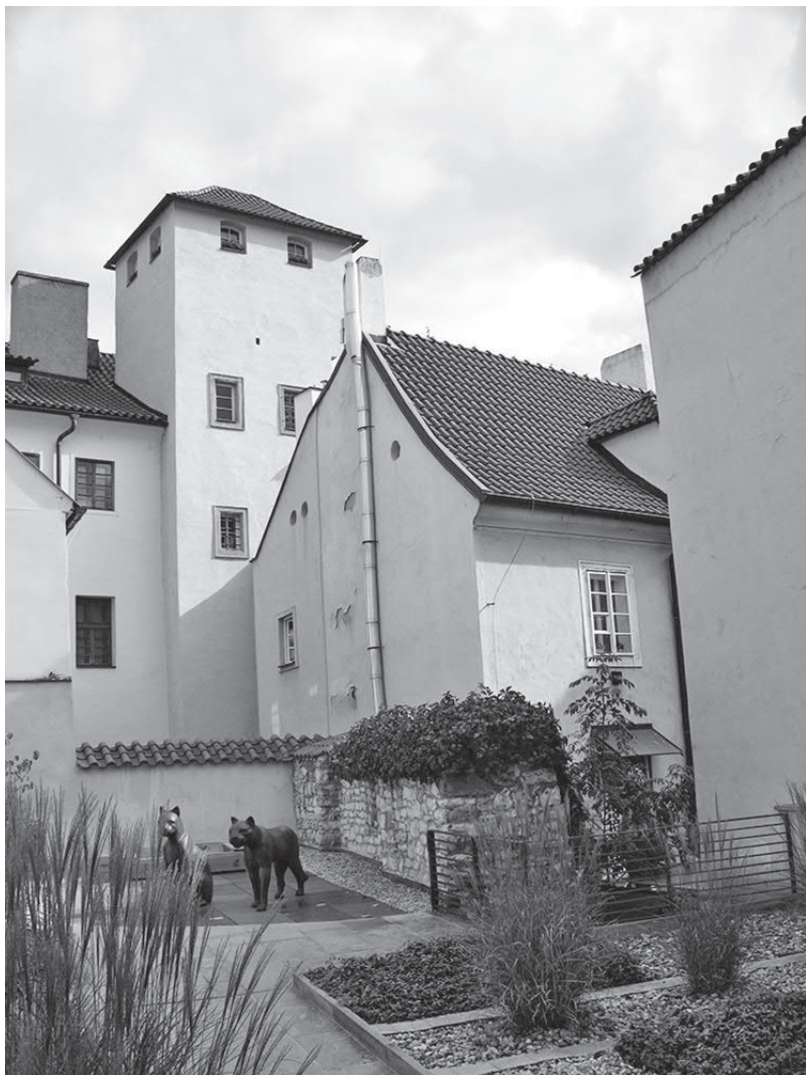
Obr. 8. Praha – Malá Strana, Mostecká čp. 273. Parcelní linii s jižním sousedem čp. 292/III tvoří hradební zeď, v současné době restaurovaná a částečně porostlá břečťanem. Směřuje na dochovanou jihozápadní nárožní věž johanitské komendy, která je dodnes ve struktuře bloku zřetelná. Foto autorka, 2017.
