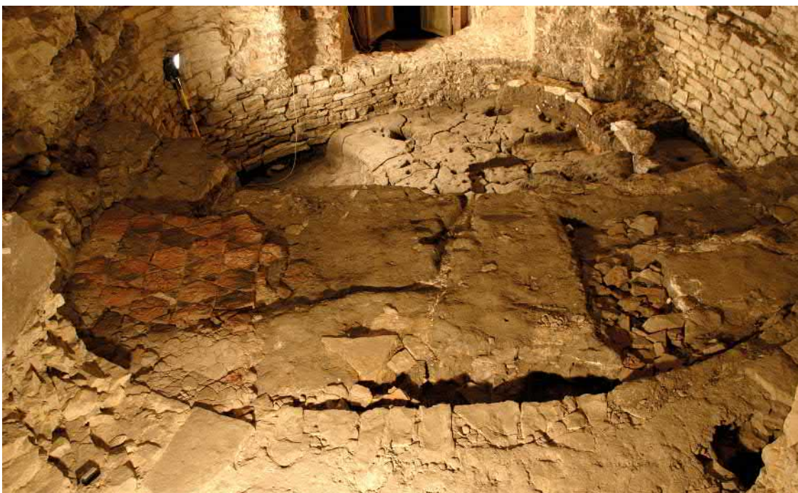
Obr. 1 Základové zdivo lodi rotundy sv. Václava. Pohled od severu, vlevo fragment původní románské keramické podlahy. Foto: M. Müller
